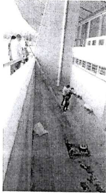
Fig. 21. Personal realizando reparaciones en el sistema de aguas lluvias.
