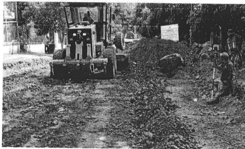
Corte de material a nivel de sub rasante para niveles
