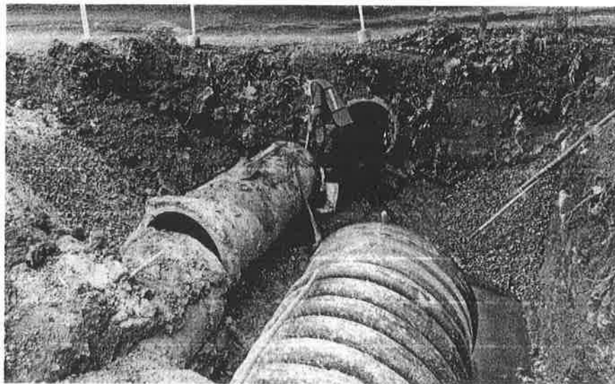
Remoción de Tubería TCR por Tubería ADS diámetro de 36"
