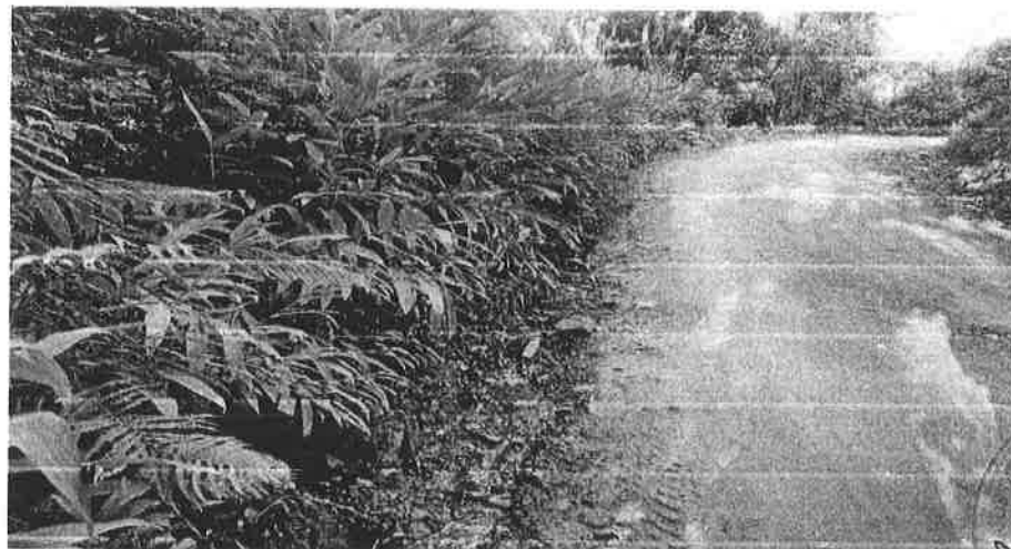
Corredero continuo, se usara subdrenaje con grava y geotextil
