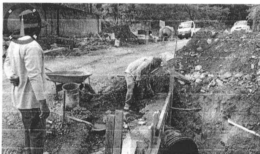
Cabezal de Concreto Ciclópeo para Tubería ADS diámetro de 36"
